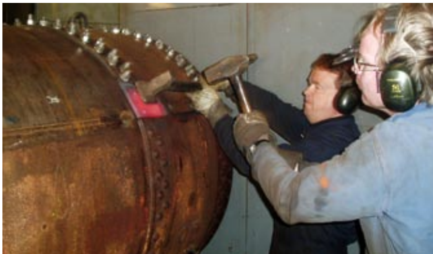
Justering av plåanliggning med hjälp av slägga och sätthammare.
