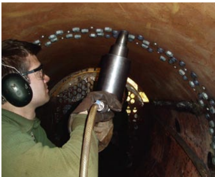
Användning av pneumatiskt mothåll.
