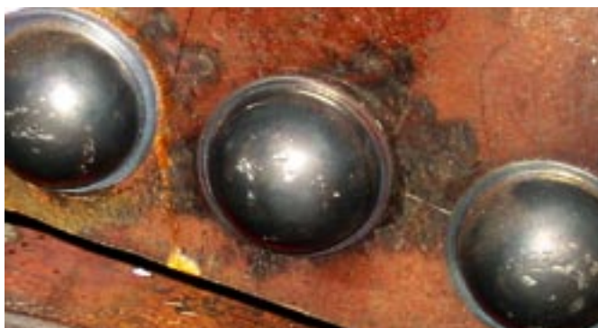
Exempel på nit med lagom skägg runt skallen.
