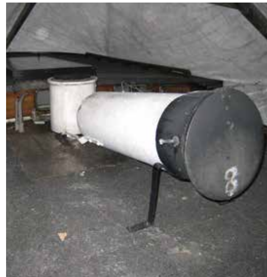
En fällbar skorsten konstruerades.
