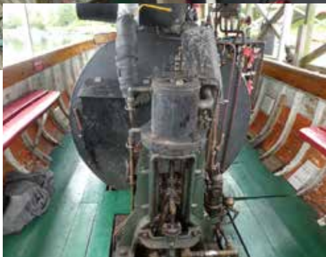
Trångt runt den stora pannan. Encylindrig maskin.
