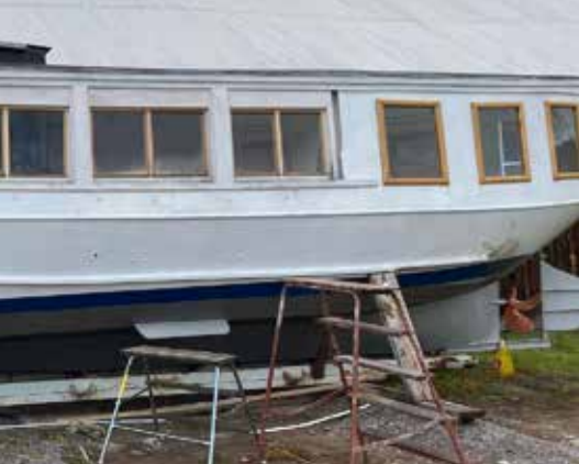
Den nya ångbåten SAGA III under byggnad.
