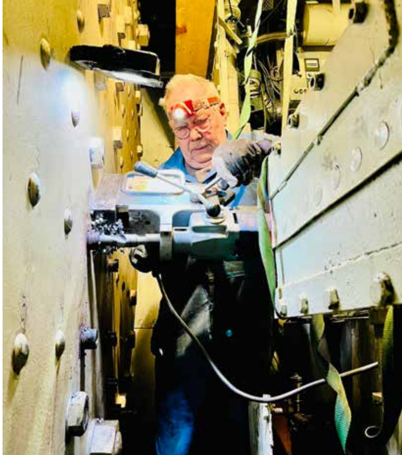
Trångt för Leif H och magnetbormaskinen. Foto: Rickard Andersson.
