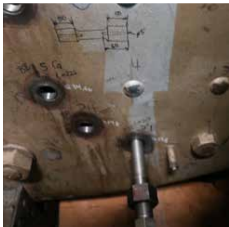
Indragning av första stagbulten.
